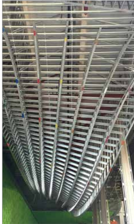
Wilshire Grand Center Porte Cochère / Los Angeles, CA
